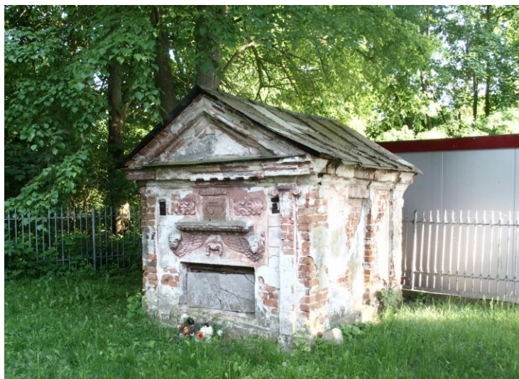
Widok od północnego-zachodu
