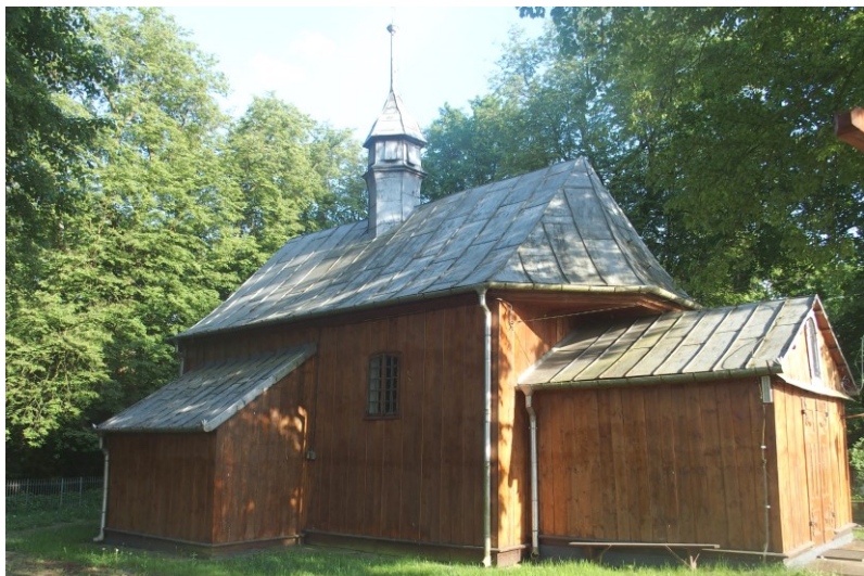
Widok od północnego-zachodu
