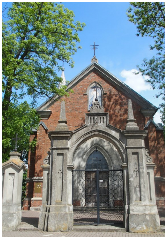
Widok od południowego-zachodu
