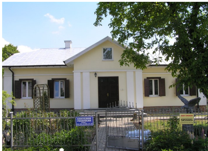
Widok budynku od północnego-zachodu
