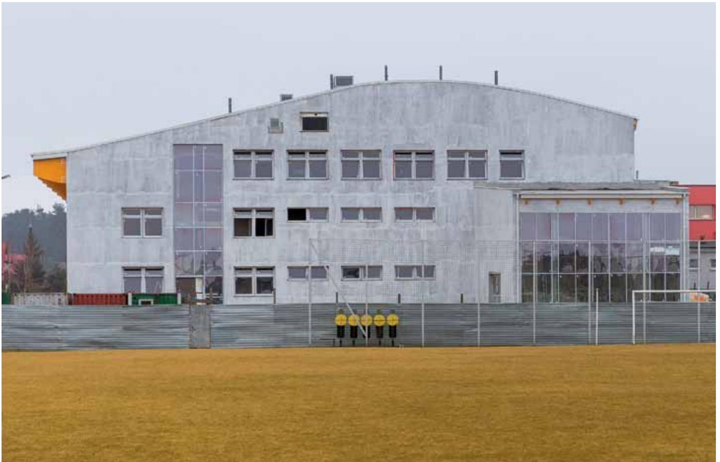
Budowa hali sportowej w Maszewie Dużym to największa gminna inwestycja w 2018 r.
