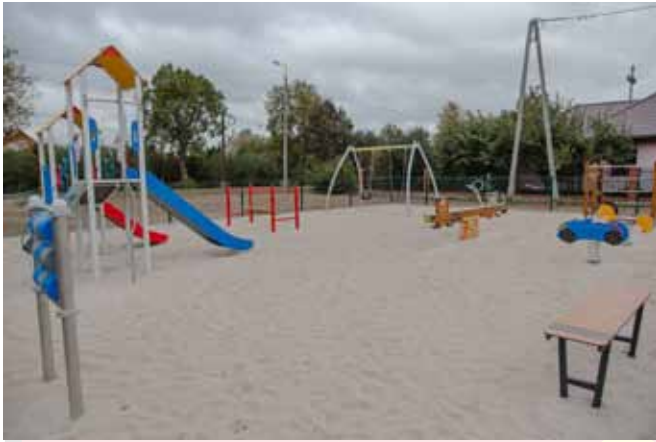
Budowa placu zabaw w miejscowości Brwilno Realizacja 2018 Wartość: 185 500,00 zł
