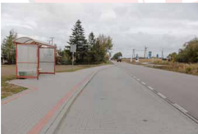
Przebudowa skrzyżowania drogi powiatowej Nr 5205W relacji Płock – granica Miasta – Draganie – Proboszczewice z drogą gminną, budowa zatok autobusowych wraz z chodnikami Realizacja 2015 Dofinansowanie dla Starostwa Powiatowego - 79 987,00 zł - wysokości 50% wartości wykonanych robót.
