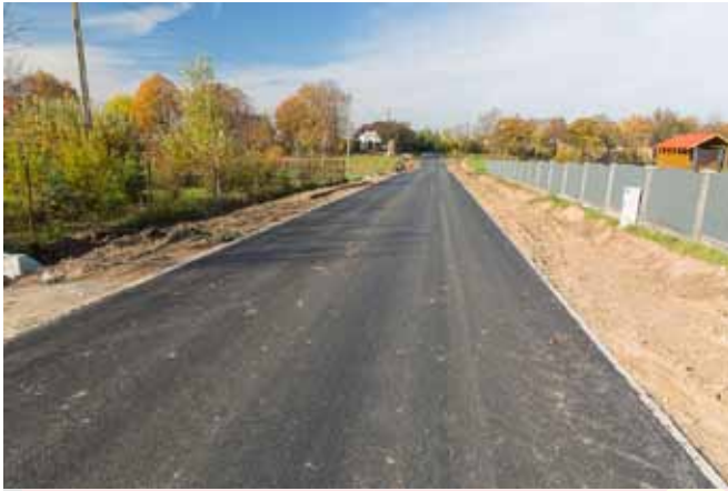
Budowa drogi gminnej w Bronowie-Zalesiu Realizacja 2015 Wartość: 643 753,28 zł
