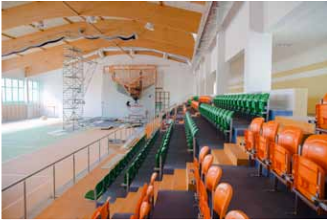
Budowa sali sportowej w miejscowości Maszewo Duże Realizacja 2016-2018 Wartość: 7 520 610,32 zł
