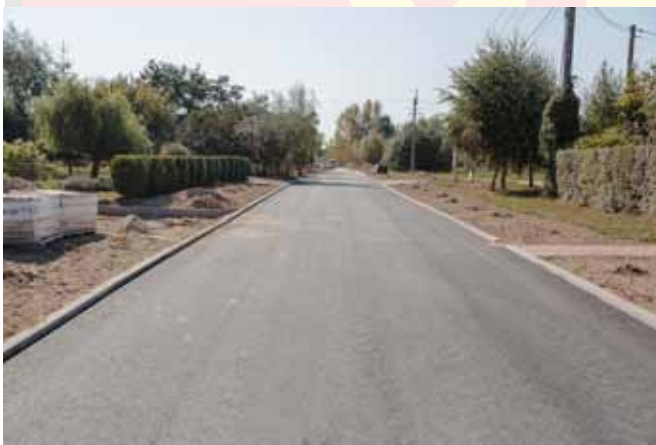
Budowa ulicy Lawendowej w miejscowości Brwilno Realizacja 2018 Wartość: 2 357 458,82 zł
