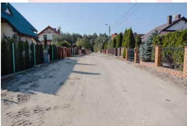
Budowa ulicy Bukowej w Maszewie Dużym Realizacja 2018 Wartość: 492 320,00 zł
