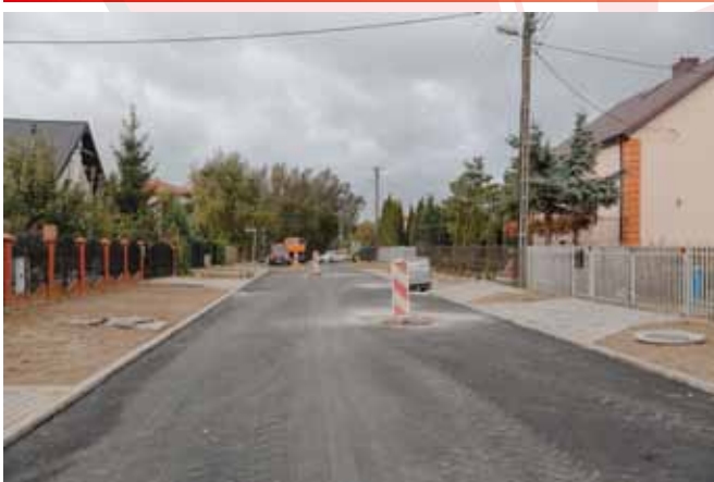
Budowa ulic na osiedlu "Podgrodzie" w miejscowości Nowe Proboszczewice Realizacja 2018
