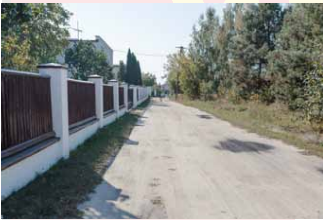
Budowa ulicy Agrestowej w Maszewie Dużym Realizacja 2018 Wartość: 416 790,00 zł
