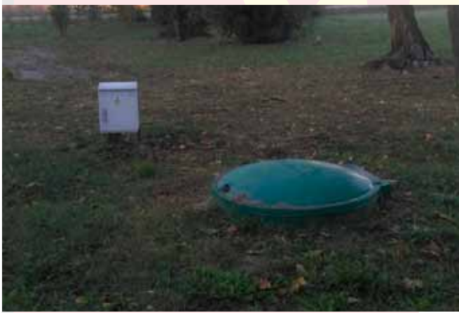
Budowa przydomowej oczyszczalni ścieków wraz z przewodami kanalizacji sanitarnej i wylotem do rowu melioracyjnego dla budynku mieszkalnego wielorodzinnego na dz. o nr ewid. 178 w miejscowości Włoczewo Realizacja 2015 Wartość: 68 790,57 zł
