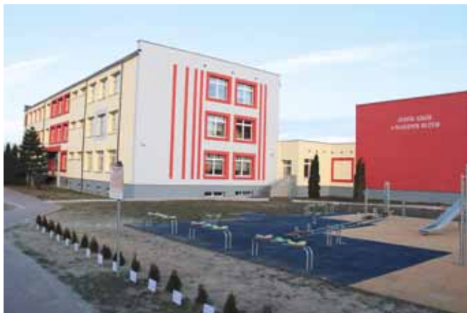
Budynek Szkoły Podstawowej w Maszewie Dużym – dziś „powiększony” o nową halę sportową.
